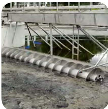
Szabadalmaztatott uszadék kihordócsiga koncentrikus úszó elszívó üzeme
