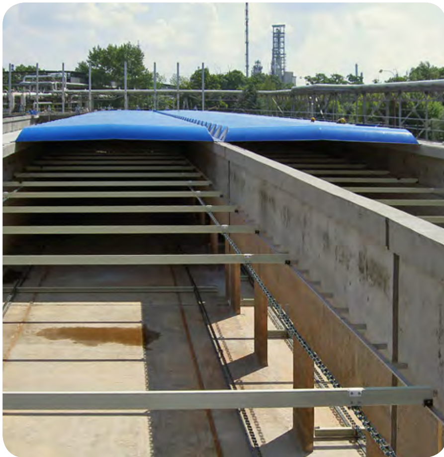
Üvegszál erősítésű műanyag burkolat API medencék fölött
