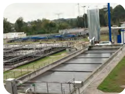
Kommunális szennyvíztelep műanyag láncos kotróval
