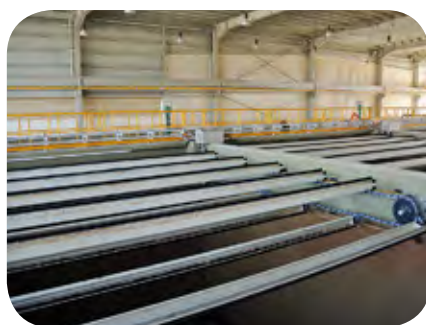
Felszíni kotrók tengervíz sótalanításához
