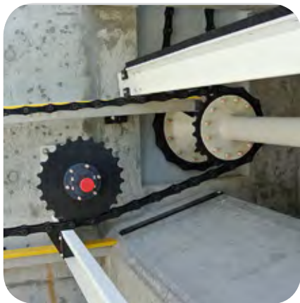
Flotálóba telepített kotrók szintetikus anyagból készülnek
