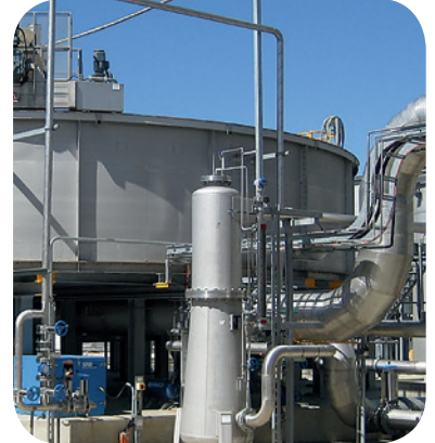
Kiemelkedő teljesítményű szaturációs rendszer, amellyel mikrobuborékok hozhatók létre és juttathatók be a flotálómedencékbe
