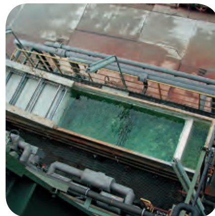
Flotáló egység teljesen műanyagból
