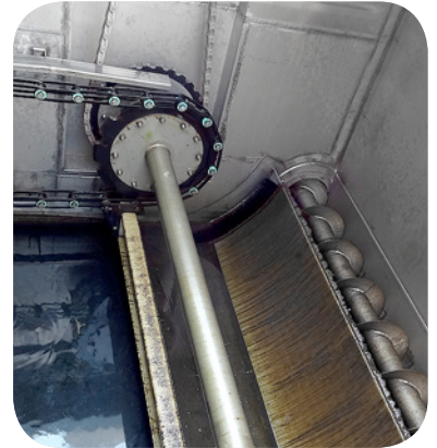
DAF kotrórendszer; rámpa és szállítócsiga segítségével történő iszapeltávolítás
