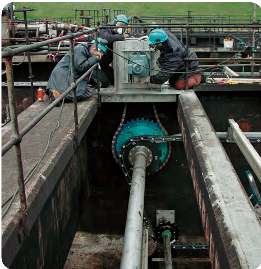
API ülepítő tartály finomító műben
