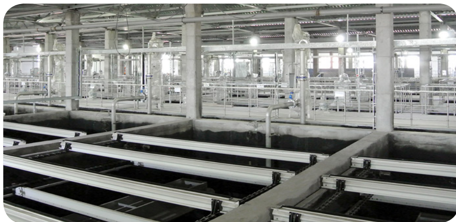
DAF-kotrók teljes mértékben műanyagból
