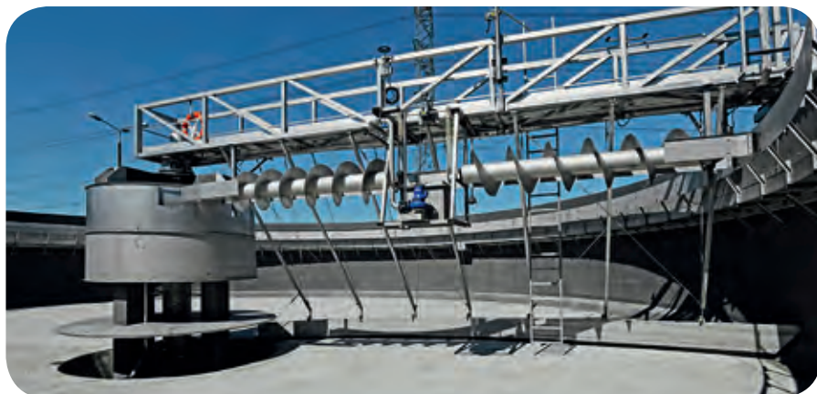
Szabadalmaztatott uszadék kihordócsiga koncentrikus úszó elszívóval
