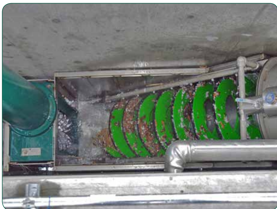
A víztelenített rácsszemetet a kihordó csiga emeli a kidobási ponthoz
