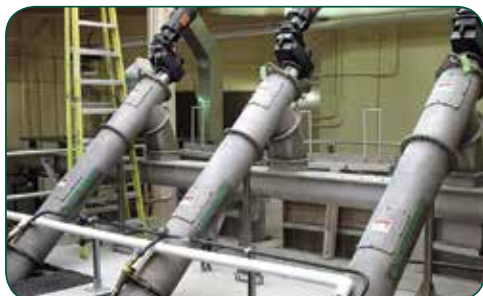
Auger Monster- rácsszemét kidobás vízszintes kihordó csigára
